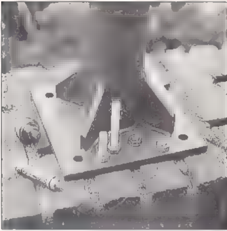
De voet waarop later de hele constructie zal rusten (met behulp van vier roestvrij stalen bouten wordt het mastgedeelte zuiver loodrecht gesteld).
